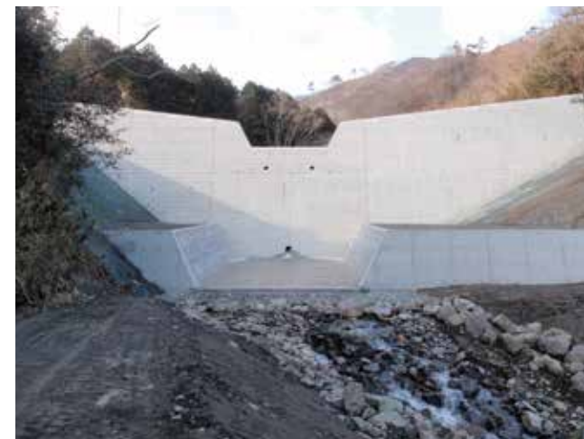
6 成松川砂防堰堤
