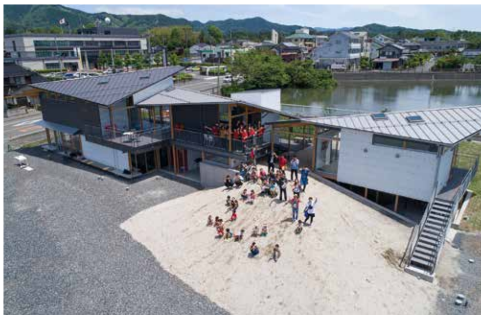
②小商いマーケットプレイス（ナギテラス）建物部分完成
