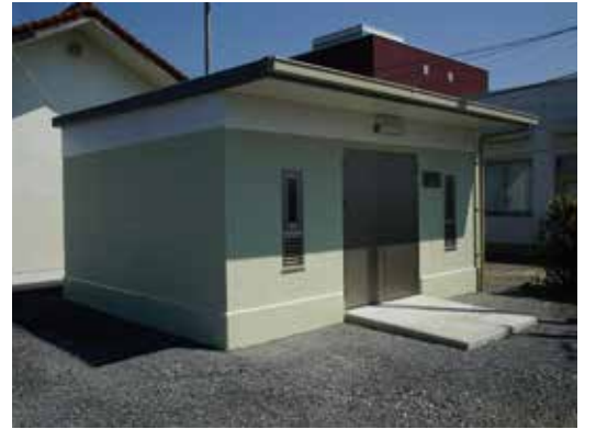
2 防災備蓄倉庫完成 (庁舎1棟、各地区18棟)
