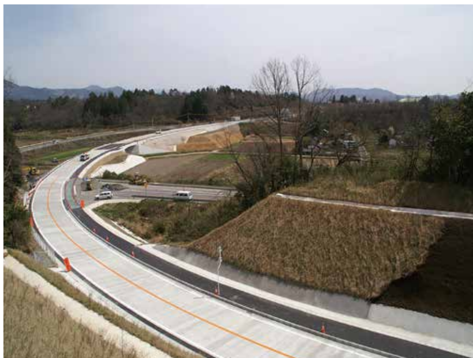
① 国道53号奈義町上町川視距改良工事完成
