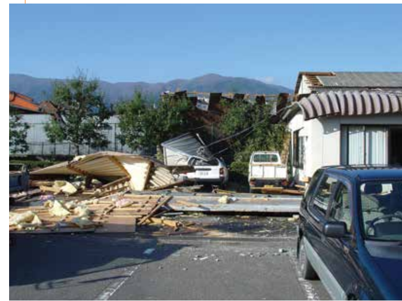
台風23号の襲来により電柱が折れ役場の車両を押し潰した
