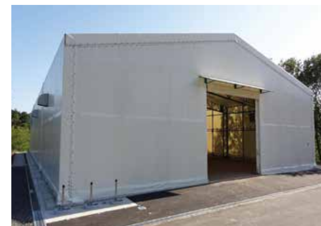
6 テント式倉庫を設置
