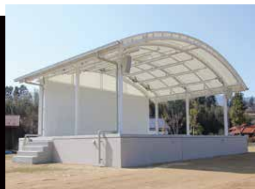
6 屋外ステージ完成
