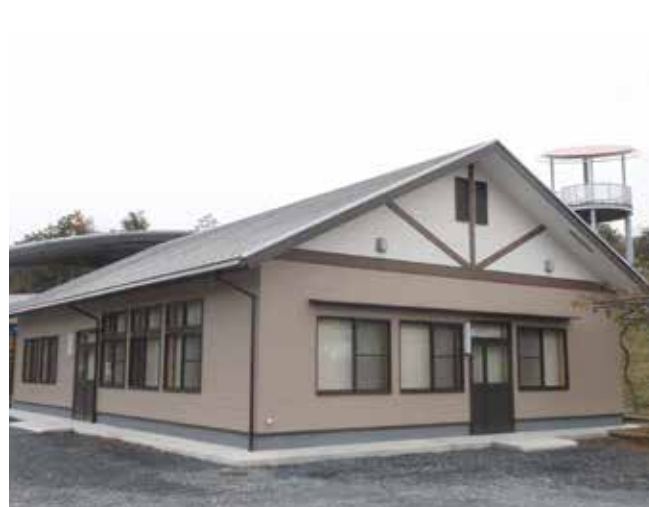
12 完成したピカリアふれあい会館
