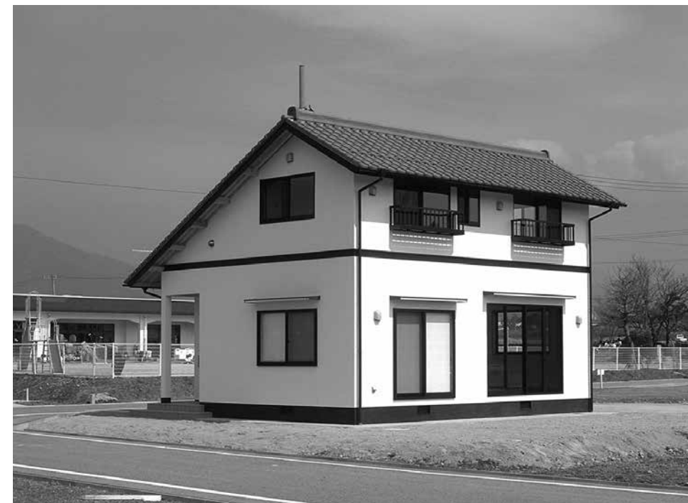
① つくし団地に整備したモデルハウス見学会が行われた
