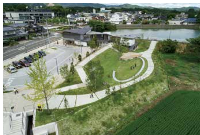
7 外構工事が完成したナギテラス
