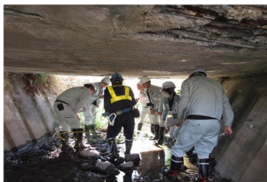
橋梁点検実習状況
