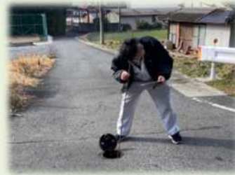
漏水調査風景
