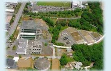
津山第2浄水場
