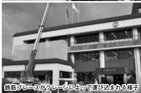
耐震化された役場庁舎。鉄筋ブレースがはめ込まれ耐震の強化が図られました
