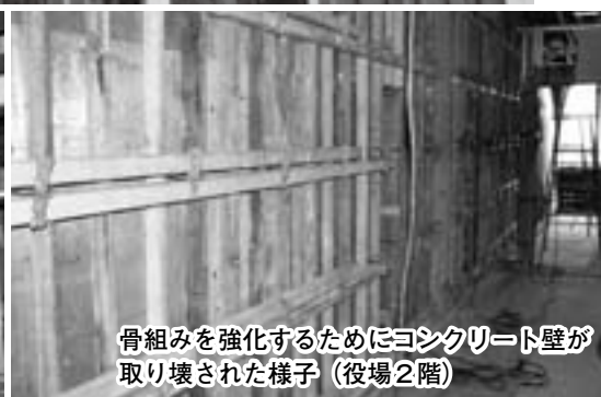
耐震化された役場庁舎。鉄筋ブレースがはめ込まれ耐震の強化が図られました
