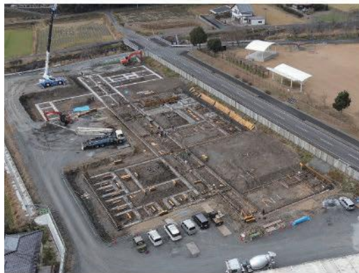
こども園の建設工事の施工状況
