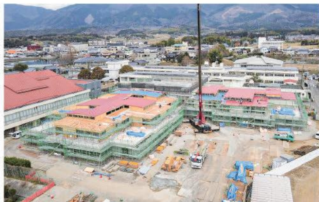
中学校の建設工事の施工状況
