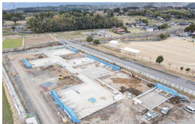
こども園の建設工事の施工状況
