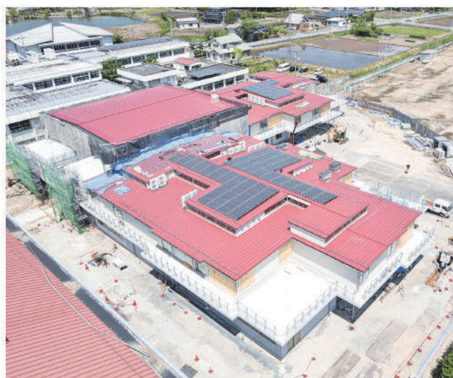
中学校の建設工事の施工状況(5月11日現在)
