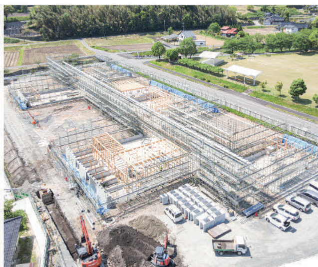
こども園の建設工事の施工状況(5月11日現在)
