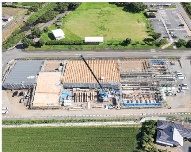
こども園の建設工事の施工状況(7月21日現在)
