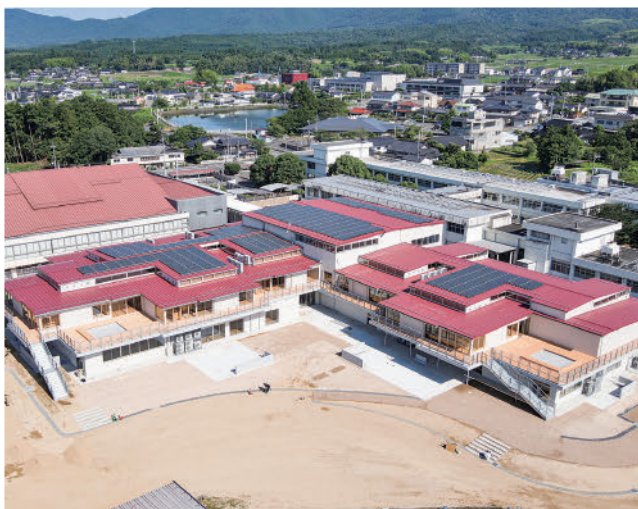
中学校の建設工事の施工状況(7月21日現在)
