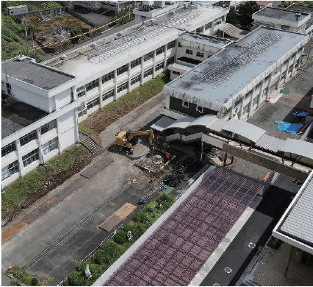
中学校の建設工事の施工状況(8月23日現在)
