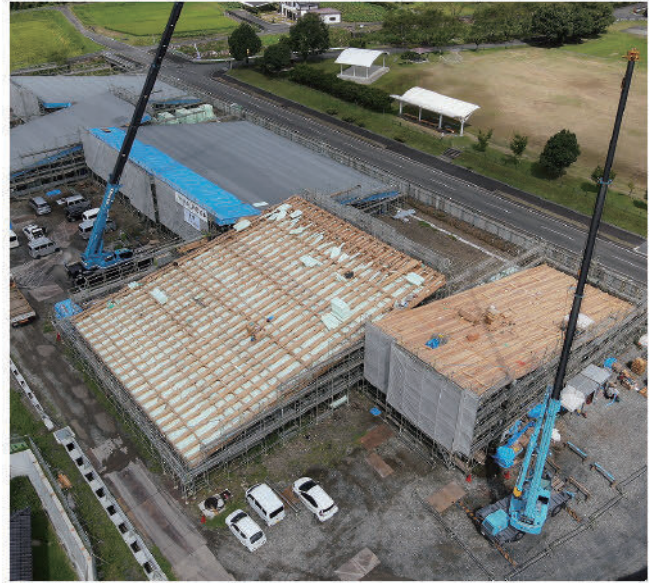
こども園の建設工事の施工状況(8月23日現在)
