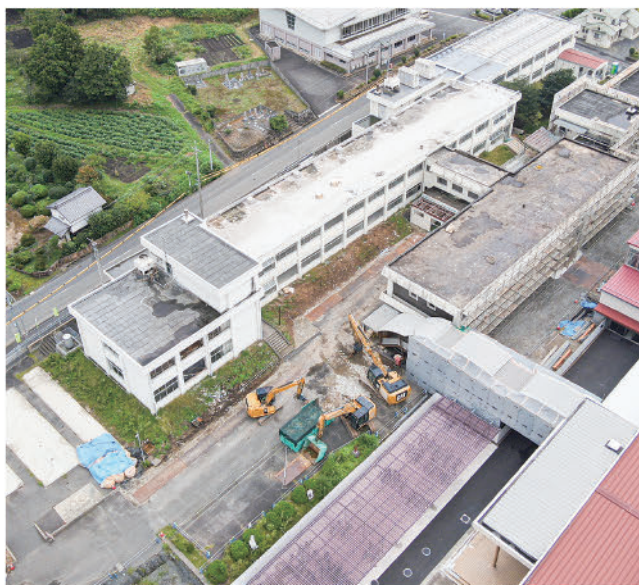
中学校の解体工事の様子(9月20日現在)
