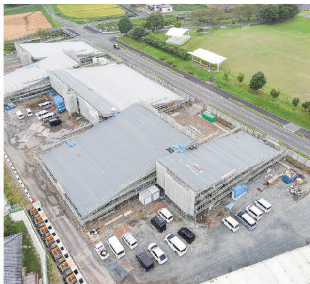
こども園の建設工事の施工状況(9月20日現在)
