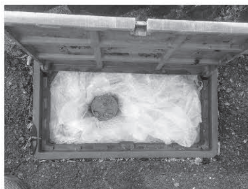
緩衝材で保温している様子
