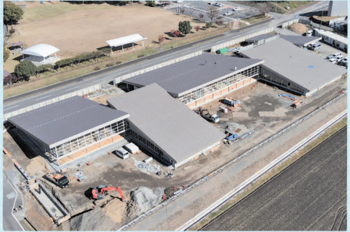
こども園の建設工事の施工状況（11月21日）
