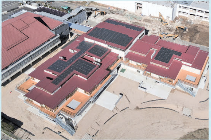
中学校の建設工事の施工状況（11月21日）
