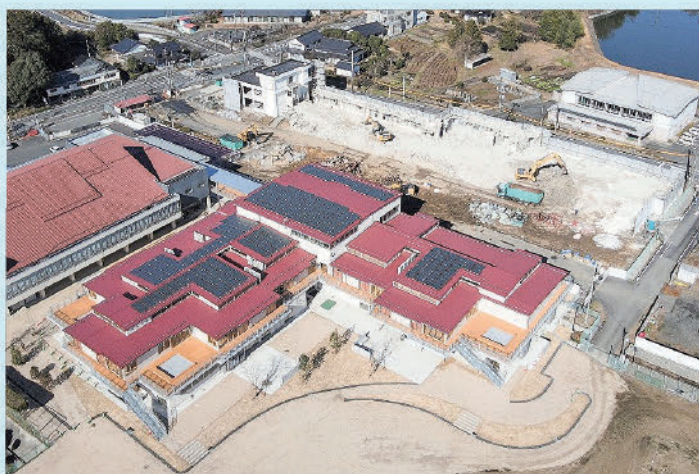
中学校の建設工事の施工状況（令和6年1月11日現在）
