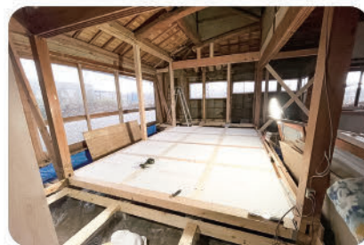
リノベーション中の古民家
