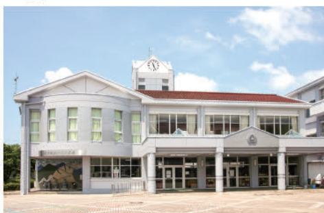
外壁塗装完成
