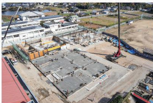
中学校の建設工事の施工状況
