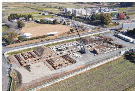
こども園の建設工事の施工状況
