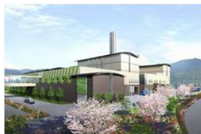
津山圏域クリーンセンター
