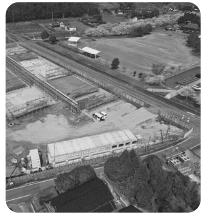
こども園の建設状況 (R5.4)
