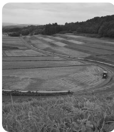
堤塘からの下流域水田
