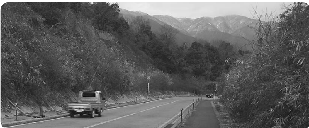
国道53号大曲り入口付近
