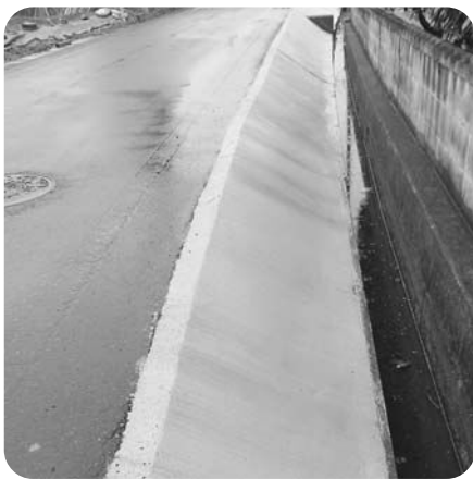
町道ののり面をコンクリート化
