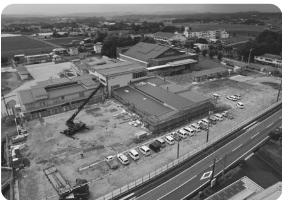
(現在の中学校建設現場)
