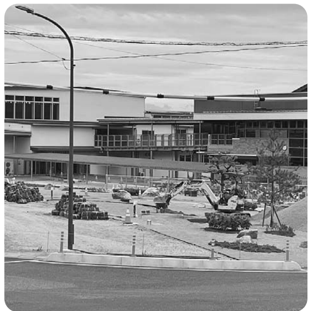
工事中の中学校エントランス
