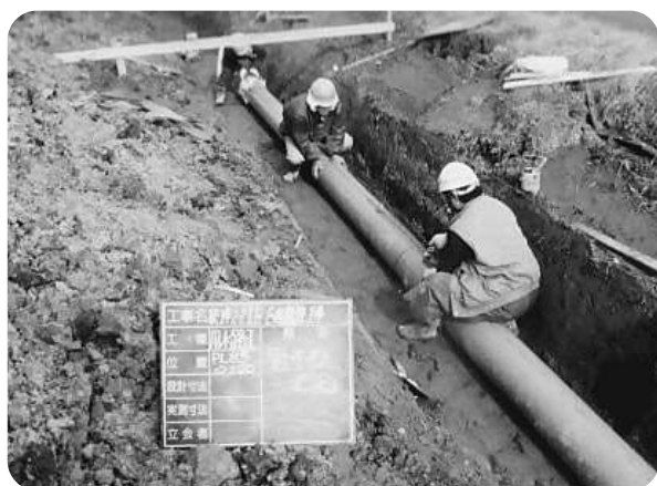
農業用水路を安全で管理しやすい管路へ更新
