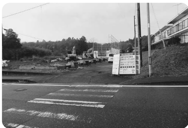
解体中の高円住宅
