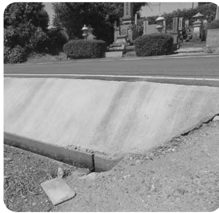
コンクリート化した法面
