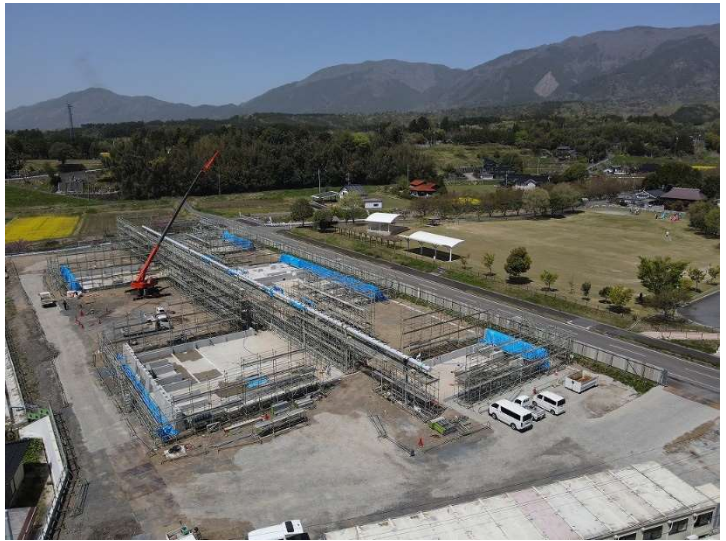
こども園南東側より撮影
