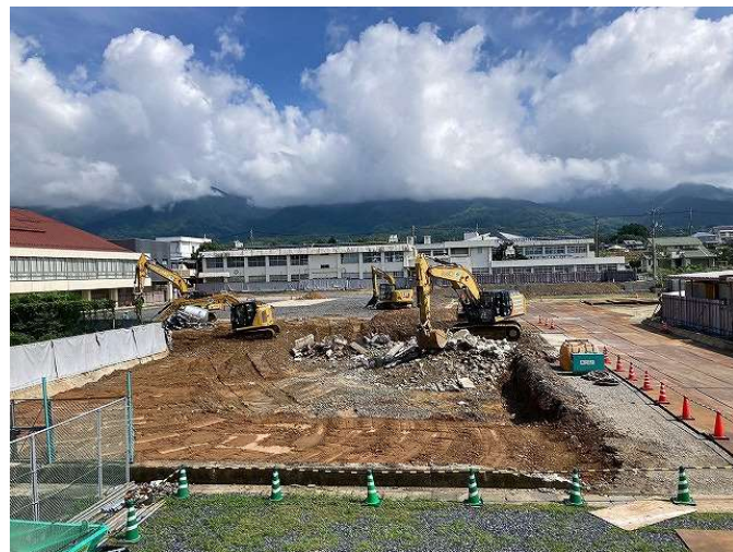
<プール解体工事の様子>
