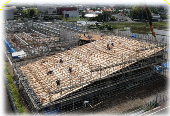
CLT 建て方工事の様子
