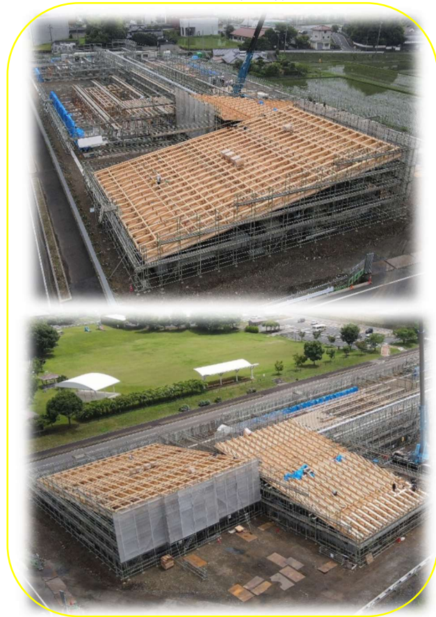
CLT 建て方工事の様子
