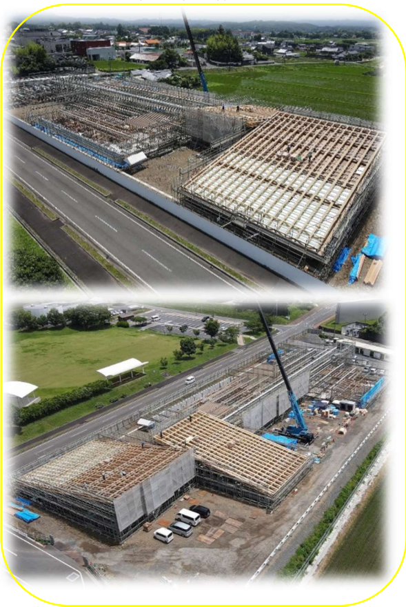
屋根工事の様子
