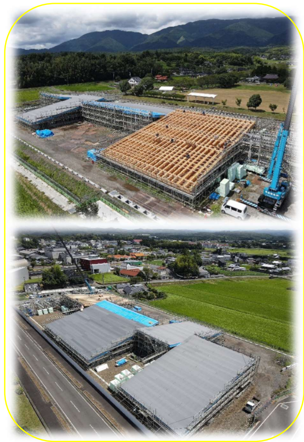
屋根工事の様子
