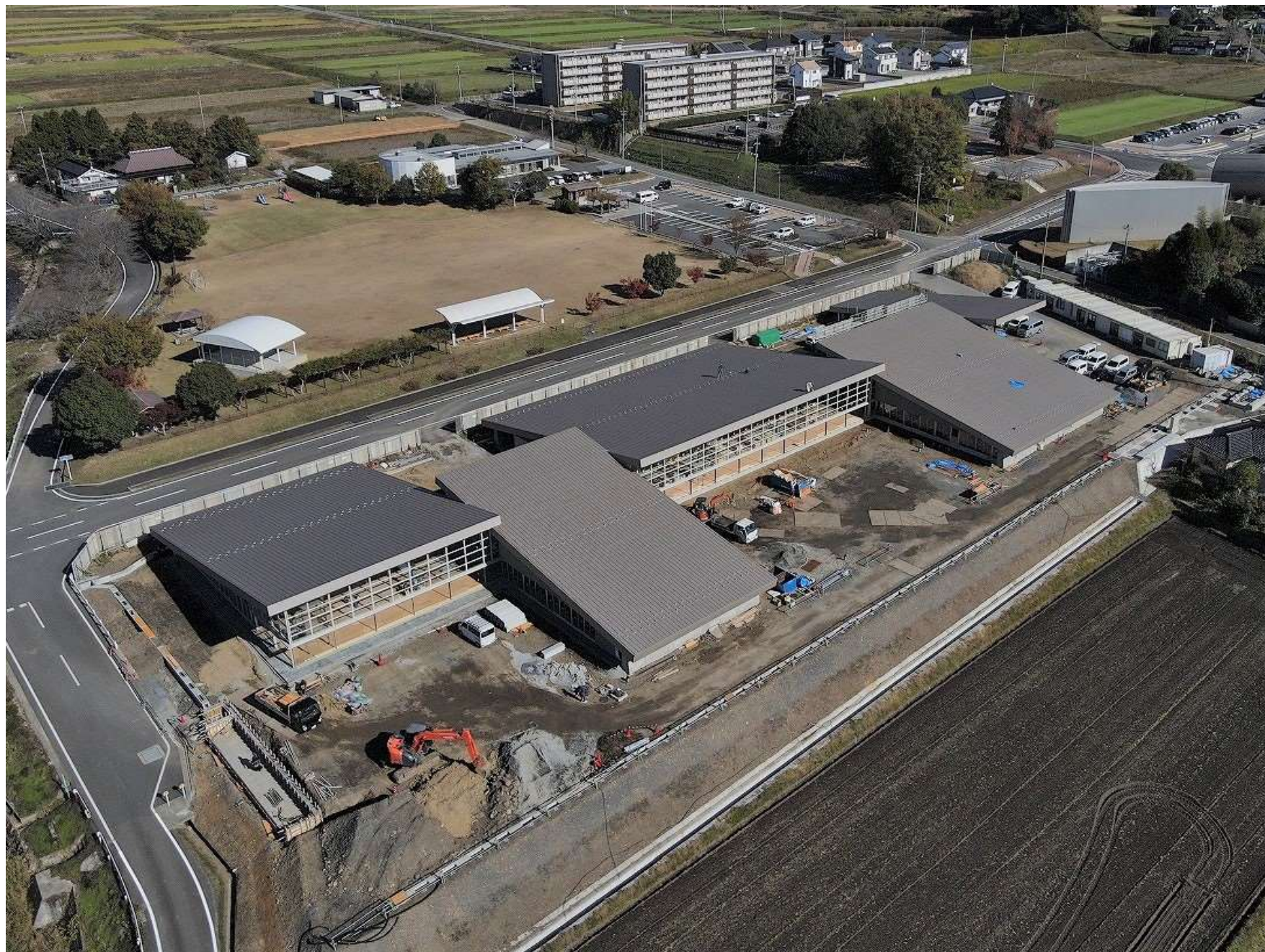
こども園の工事進捗写真(11月21日撮影)
