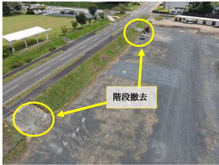
<既存の階段と植栽の撤去作業の様子>
