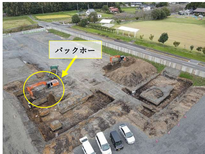
<こども園0歳児・2歳児棟の掘削工事の様子>
