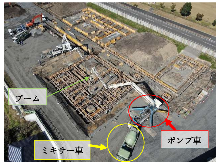
<コンクリート打設の様子>
