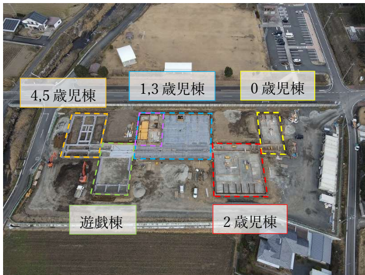
こども園真上からの撮影(打設後の様子)
