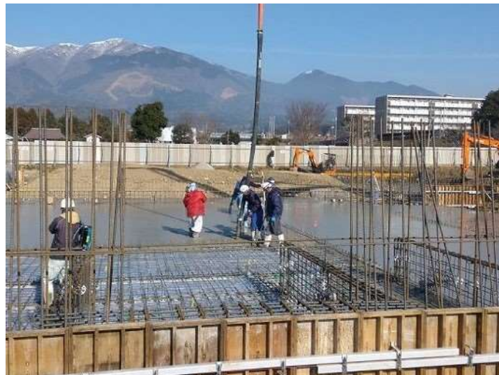
2歳児棟の土間コンクリート打設の様子
