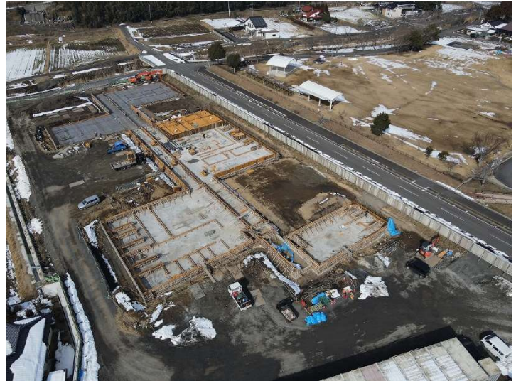
こども園南東側より撮影
