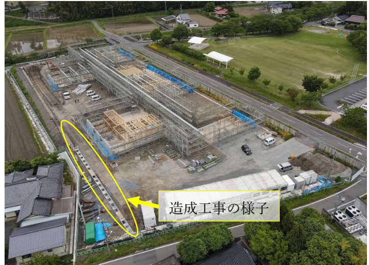
こども園南東側より撮影
