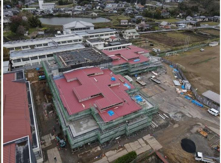
ナギヒロバ棟…躯体コンクリート打設(3回目)と屋根工事
