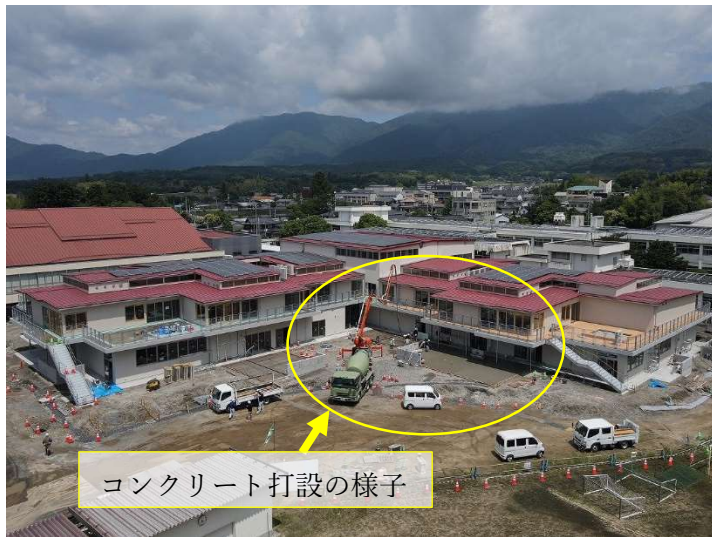
中学校南東側より撮影
