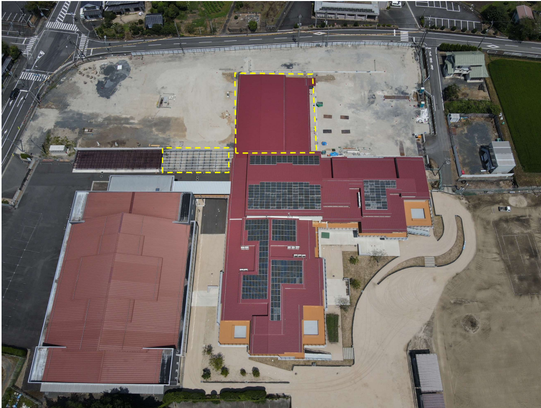
外構工事・駐輪場工事
