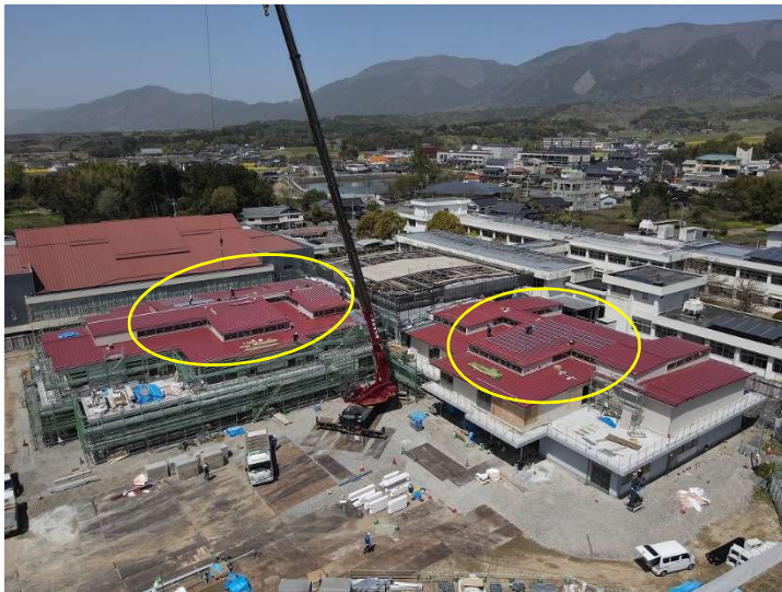
太陽光パネル設置準備の様子
