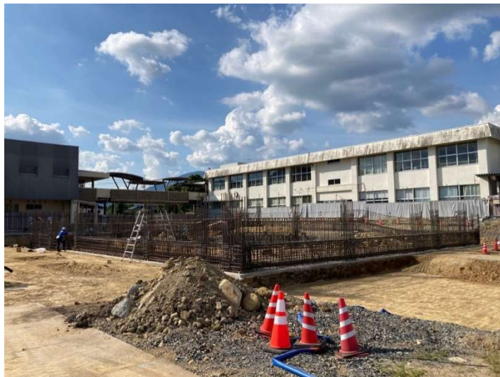
<中学校ナギヒロバ棟の鉄筋組立の様子>
