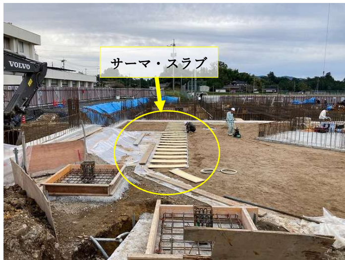
<サーマ・スラブ施工の様子>
