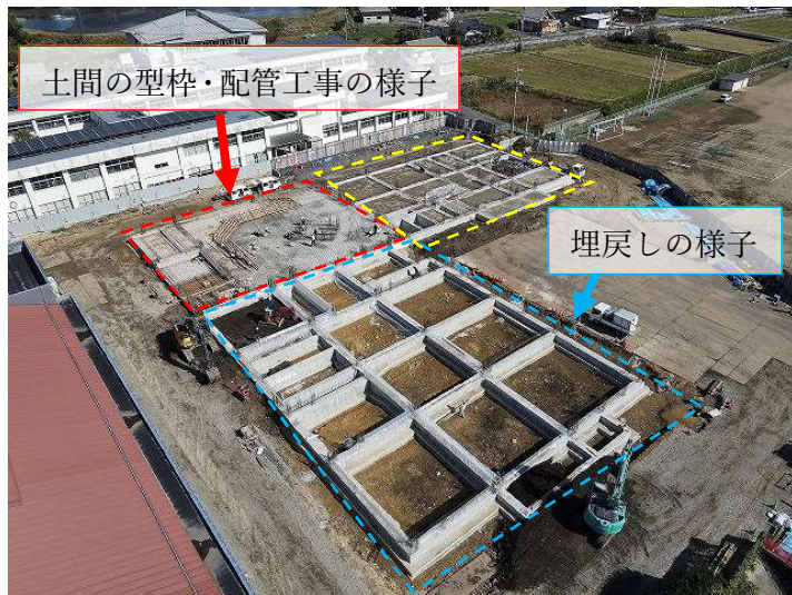
<中学校南西側より撮影>
