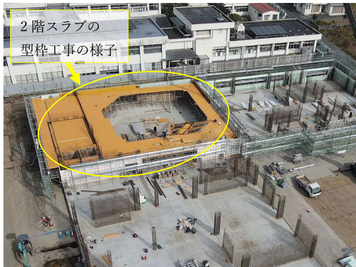
<ナギヒロバ棟の2階スラブの施工状況>
