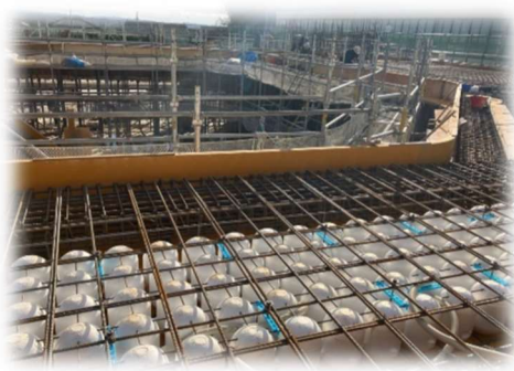
中空スラブの施工の様子
