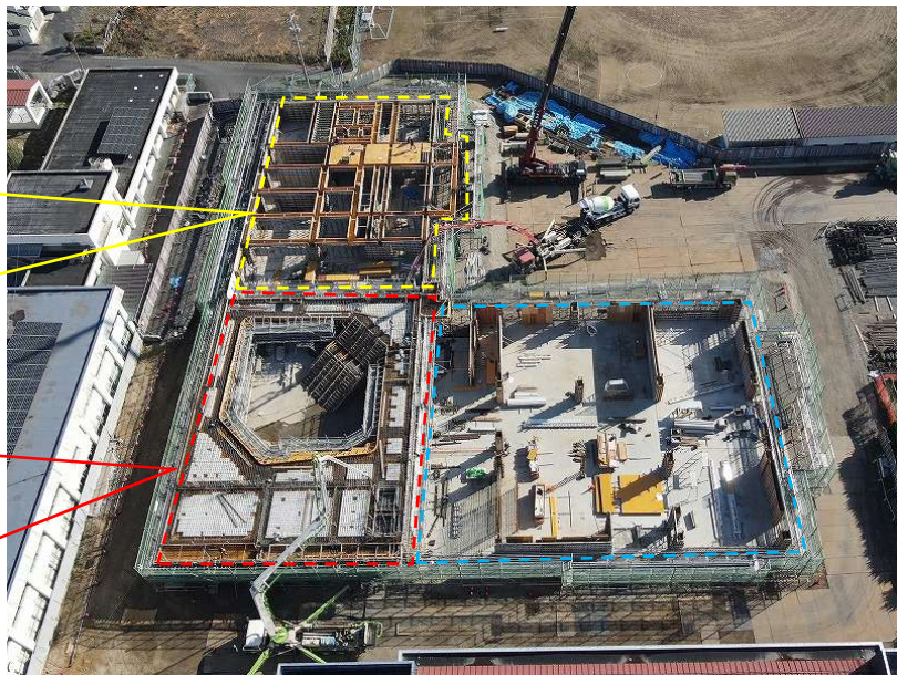
コンクリート打設の様子(中学校西側より撮影)
