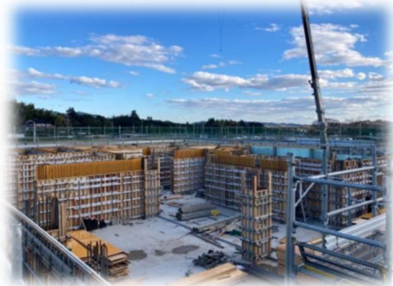
型枠工事の様子
