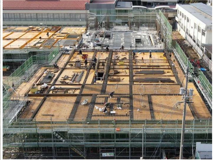
ナギヒロバ棟…2階柱・壁の配筋工事
