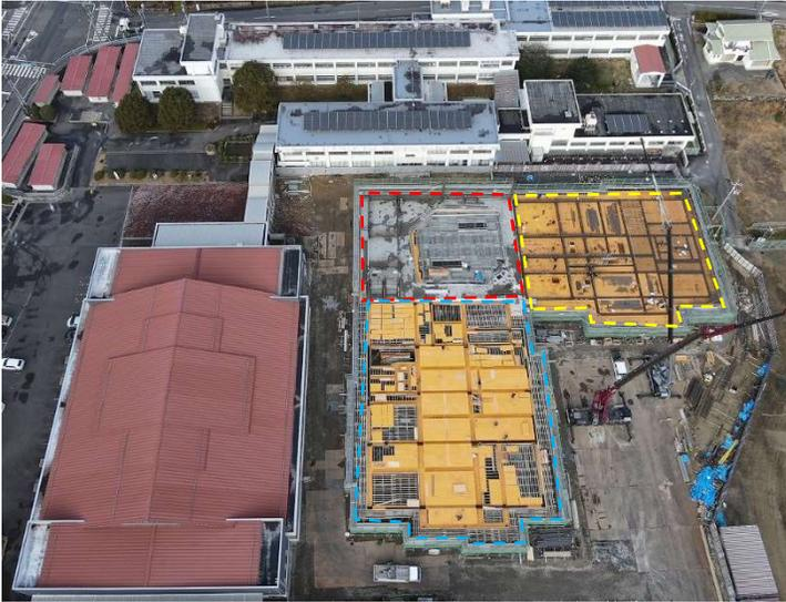
梁・スラブの鉄筋組立て作業の様子
