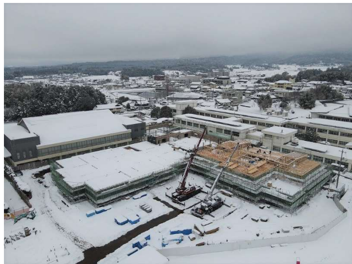
中学校南東側より撮影
