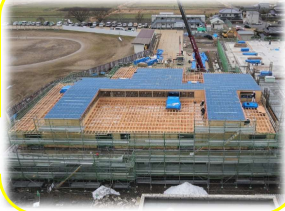
ガラス・サッシ取り付け工事の様子
