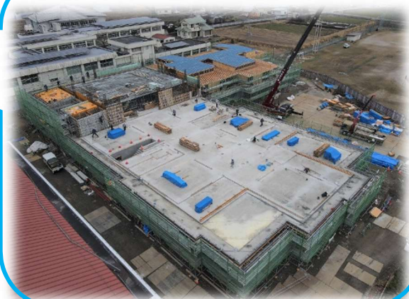
木造建て方工事準備の様子
