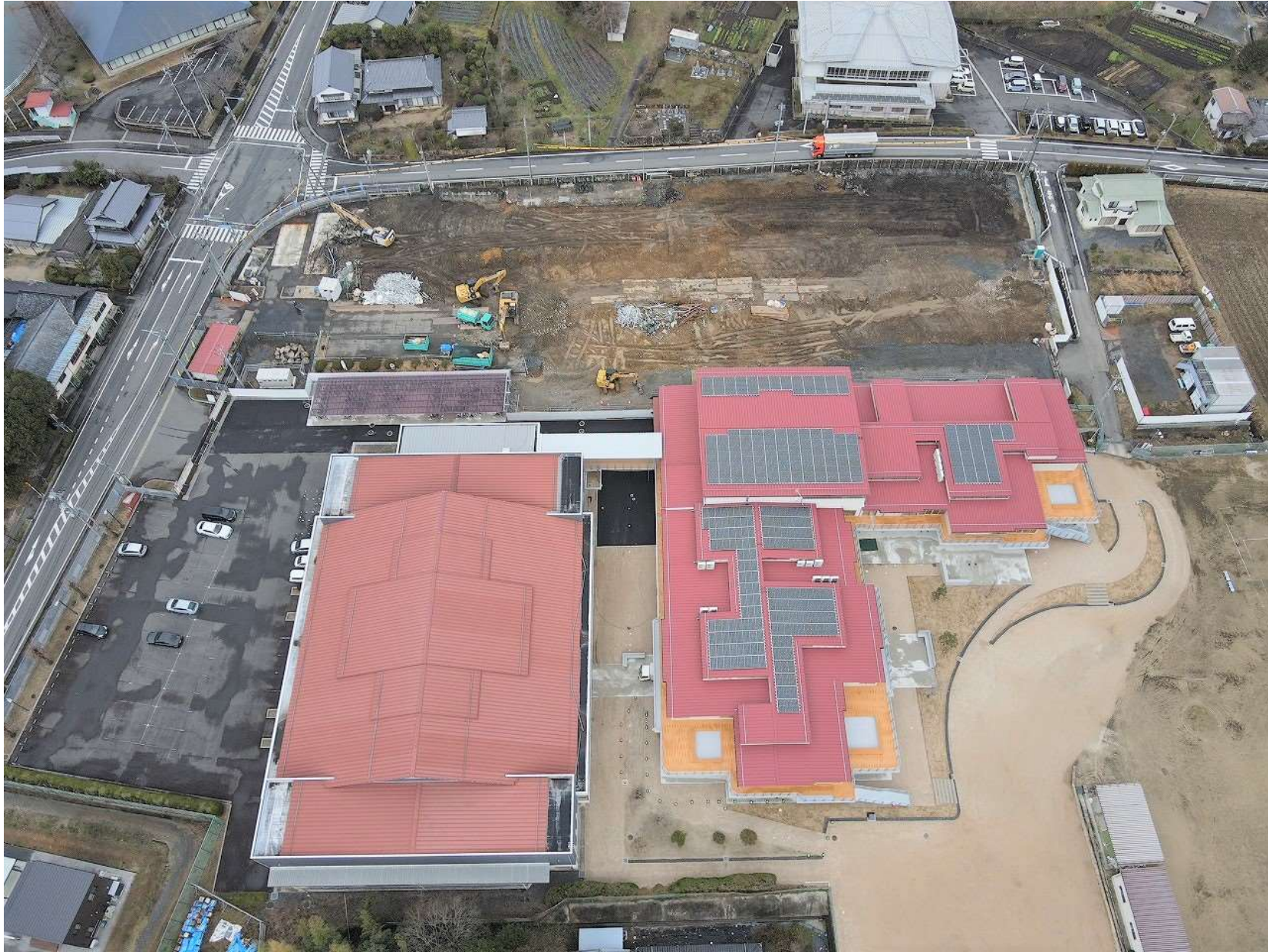
中学校解体工事の様子(令和6年2月22日撮影)
