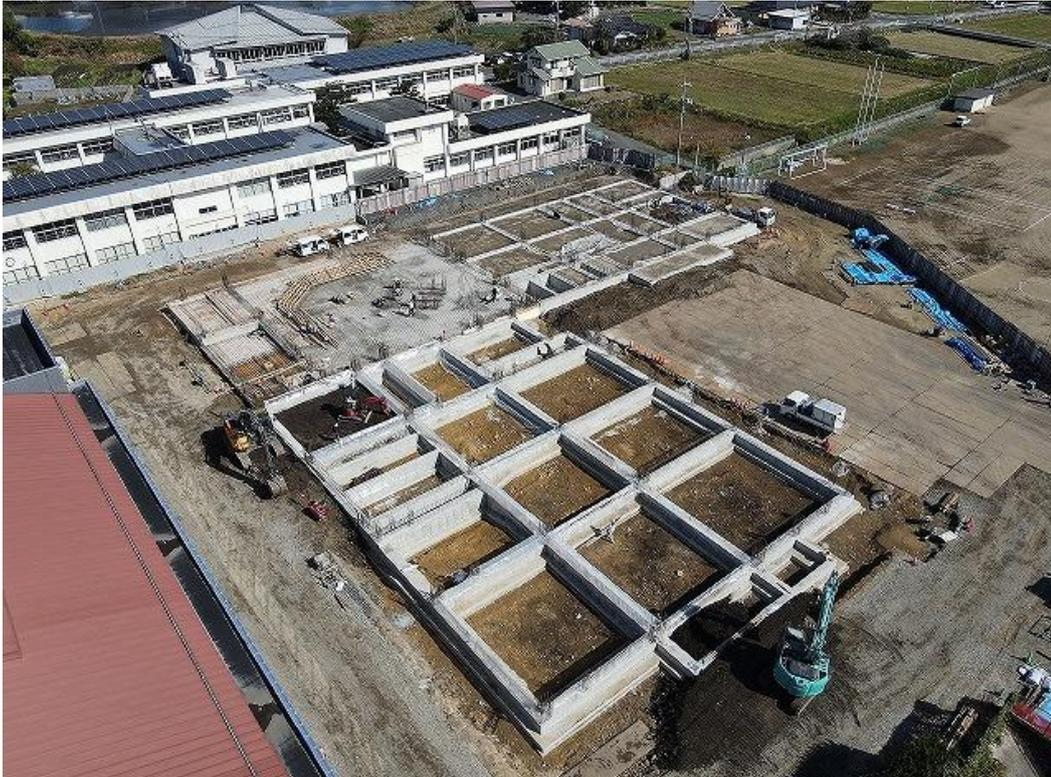
中学校では、10月中は新校舎基礎部分の鉄筋組立工事、型枠工事、基礎コンクリート打設工事が行われました。
